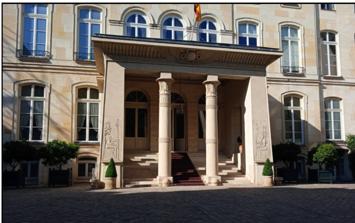
L'entrée de l'hôtel de Beauharnais, dans le 7 ème arrondissement
